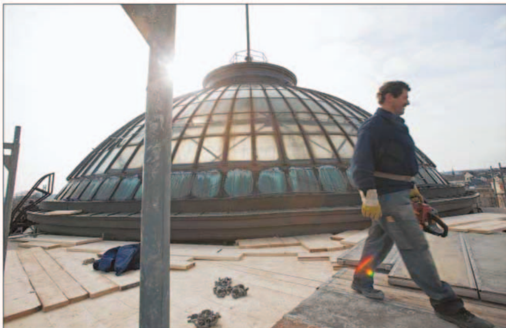
Dem Kurhaus aufs Dach gestiegen. Die markante Kuppel wird komplett neu verglast.
